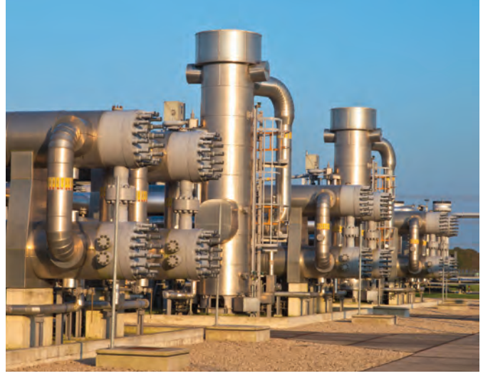
المشروع يشمل إنشاء محطة لمعالجة الغاز
